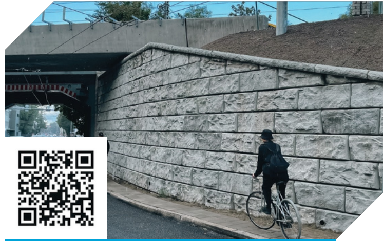
Zobrazené bloky: PC blok 710 mm (vľavo), XL blok s dutým jadrom 2 440 mm (v strede), samostatne stojaci blok s dutým jadrom (vpravo).
